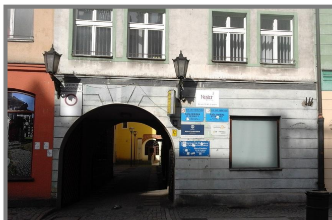
Fot. Elewacja w części uporządkowana – rok 2017
